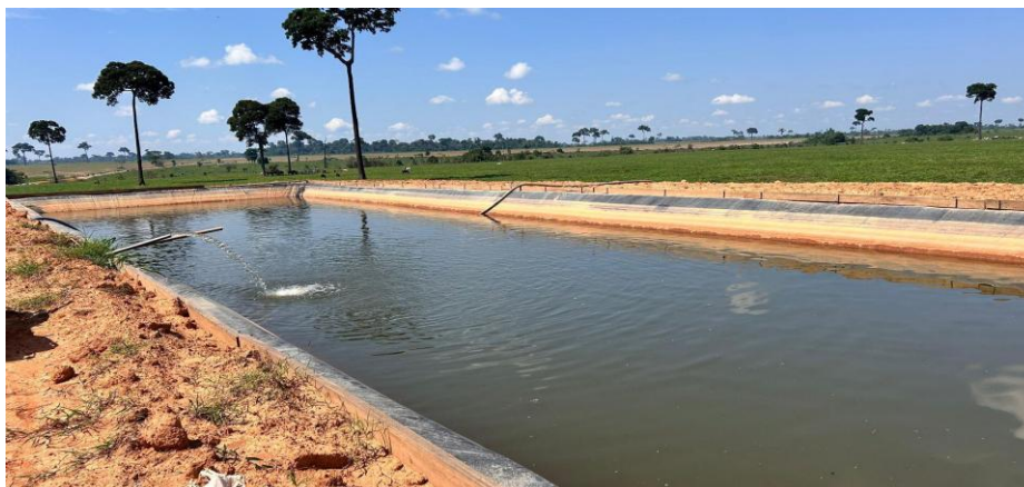
Figura 3 - Reservatório para captação e armazenamento de água e tratamento da Fazenda Nelore.
