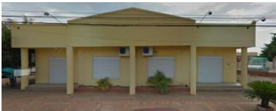
Figura 1 – Vista da entrada do prédio provisório do campus Rio Branco
